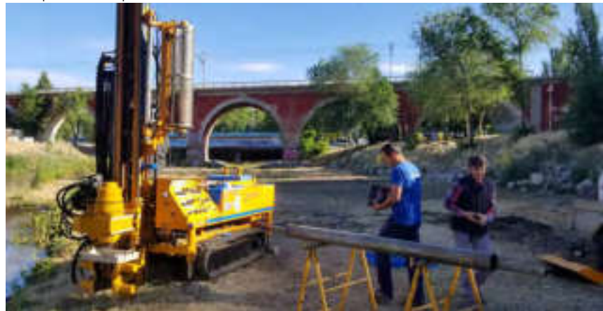
v Preparación de la perforadora
