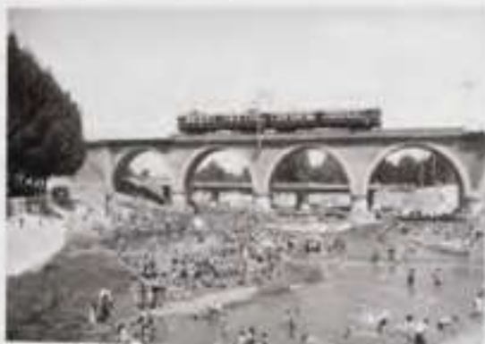
Fotografía 1. Puente de los Franceses (1942)
