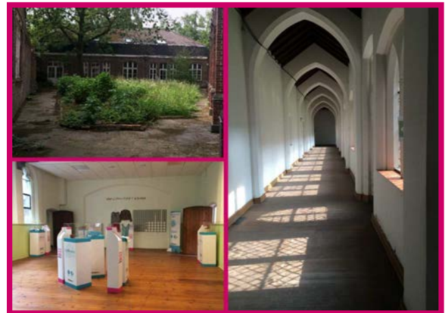
Le couvent des Clarisses, en cours de réhabilitation
