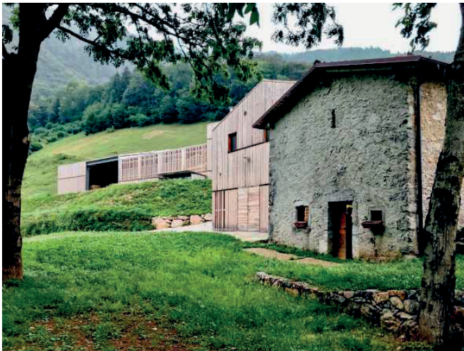
2 Contrada Bricconi Homestead, Oltressenda Alta, Bergamo (I)
