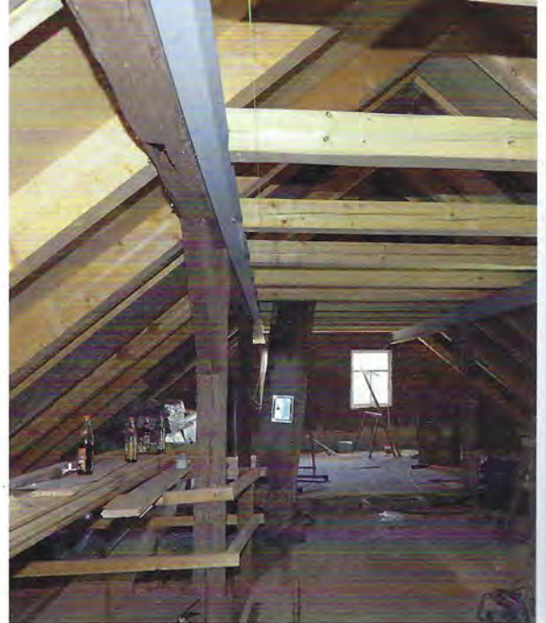
◀ Die Tragkonstruktion musste umfassend erneuert und verstärkt werden
