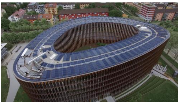
Das neue Rathaus im Stühlinger in Freiburg: als Nullenergiegebäude geplant und umgesetzt. Messungen aus den Jahren 2018 und 2019 zeigen: das Konzept funktioniert. © Fraunhofer ISE
